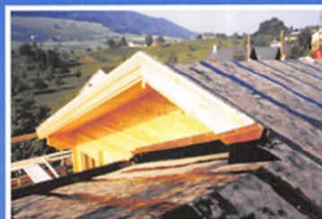
Abdichtung f.begrüntes Schrägdach.
