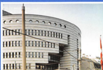
BVB Tramhüsli Aeschenplatz.
