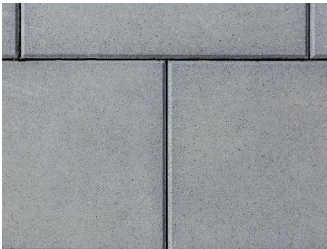
Abb. 9: Betonplatten mit gefasteten Kanten
