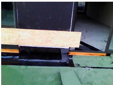
Aufnahme der Situation vor dem Schweißen dieses Anschlusses. Die Bauteiloberfläche im Fadenkreuz ist ca. 1,2 °C kalt.
