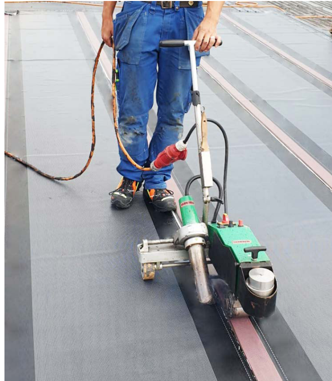
Abb. 4: Verschweissen mit Heissluft z.B. Verschweissung der Überdeckung 1-Lage bituminös
