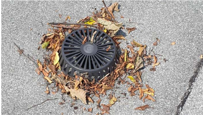
Abb. 20: Mit Laub verschmutzter Dachwassereinlauf
